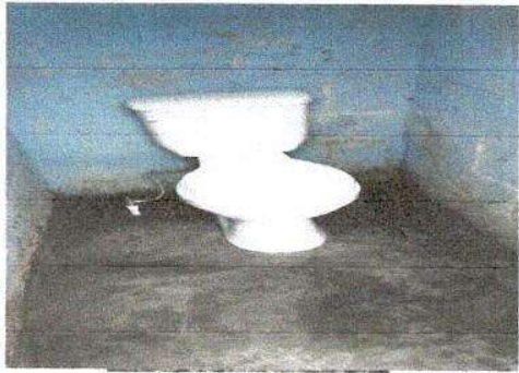
Foto7: 6.5. SUSTITUCIÓN DE PISO DE TORTA DE CONCRETO EN SANITARIOS
