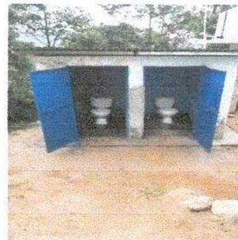
Foto 10: 10. SERVICIOS SANITARIOS Y SUS ACCESORIOS
