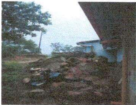
Foto 9: 7.2. CANALES Y BAJADAS DE AGUA PLUVIAL
