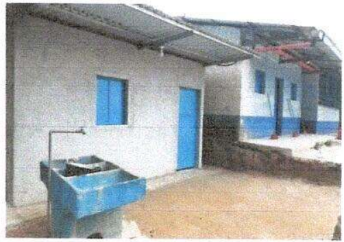
Foto 2: 1.CUBIERTA DE LÁMINA EN COCINA
